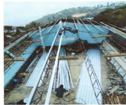
Foto 2: colocación de tuvos y pintura de estructura metálica
