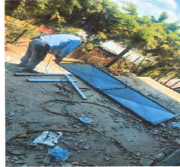
Foto 4: reparación y pintura de puertas de sanitarios
