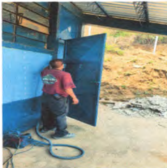
Foto 5: pintura de puertas de las tres aulas
