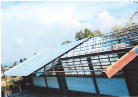
Foto 3: colocación de techo nuevo
