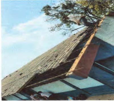
Foto 1: desmontando techo anterior
