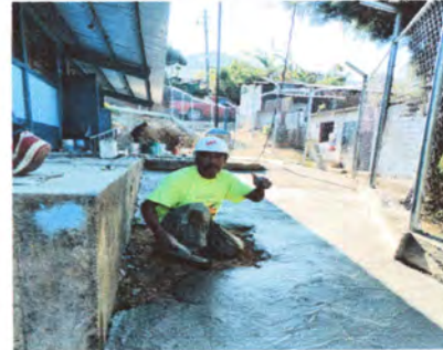
Foto 6: fundición de plancha de concreto
