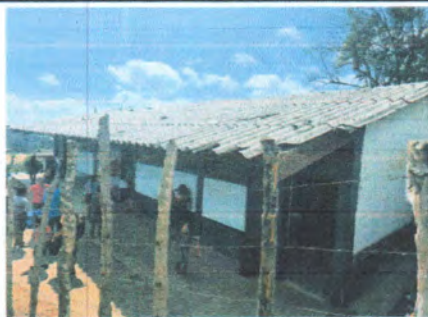
FOTO 2: PINTURA EN MUROS INTERIOR Y EXTERIOR
