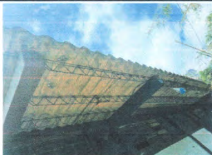
Foto1: SUMINISTRO E INSTALACIÓN DE LÁMINA TROQUELADA CALIBRE 26 Y REFORZAMIENTO DE ESTRUCTURA METALICA Y PINTURA
