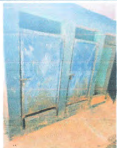
Foto: 5 REMOZAMIENTO DE PUERTAS
