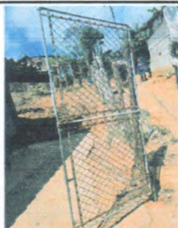
Foto3: REMOZAMIENTO EN MURO PERIMETRAL
