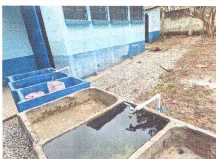
Foto 5: Red de Agua Potable Finalizada
