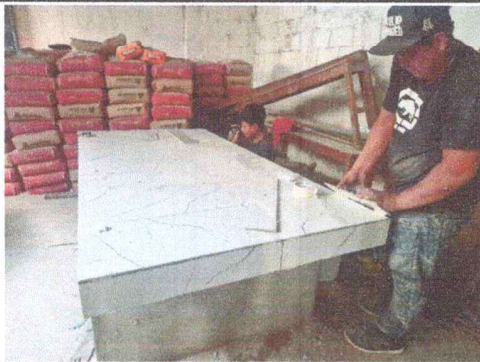
Foto 3: Reparación en el área de cocina
