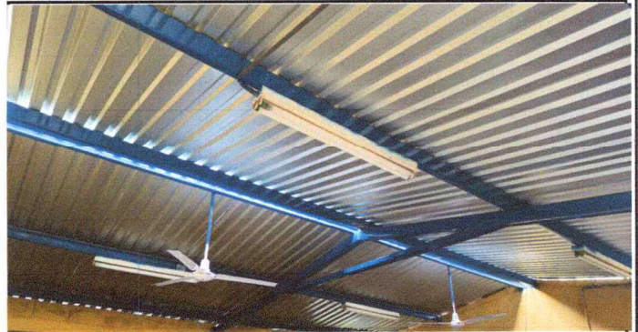
FOTO 2: cambio de lamina sensilla a lamina troquelada de aulas
