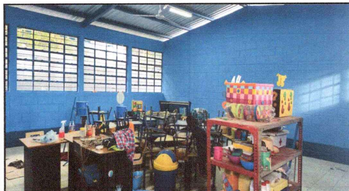
Foto3: sustitución de pintura interior y exterior
