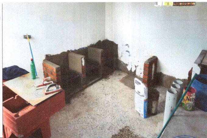
Foto: 6 repello de paredes interior y exterior area de cocina y en partes dañadas
