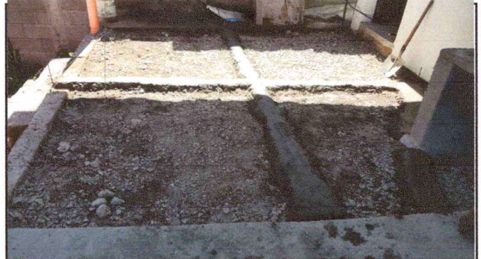
Foto4: sustitución de losa de patio, fundición y acabado area de cocina
