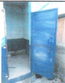
Foto 3: Instalación de puertas
