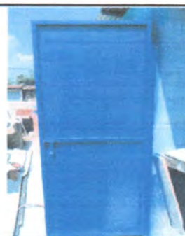
Foto 4: Reparación de puertas
