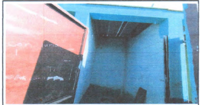
Foto 4: Reparación de puertas
