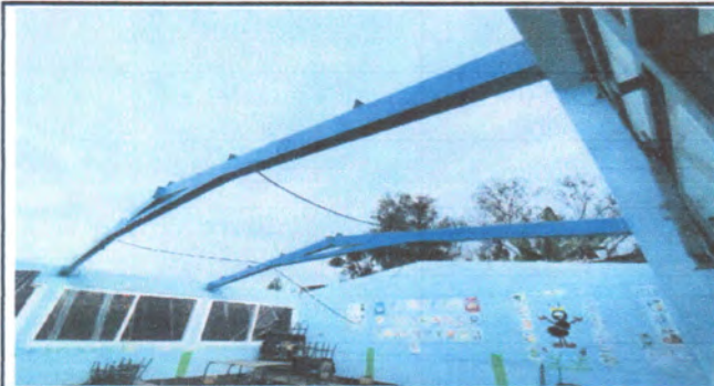
Foto 1: Sumistro e instalación de lamina troquelada calibre 26
