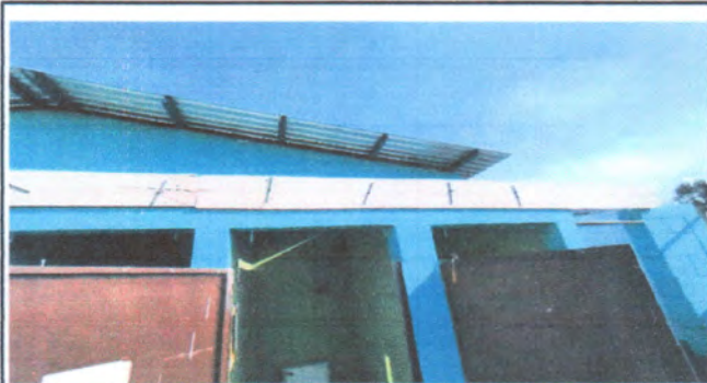
Foto 3: Instalación de puertas
