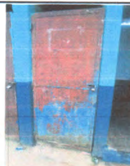
Foto4: REPARACIÓN DE PUERTAS
