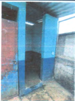
Foto3: INSTALACIÓN DE PUERTA
