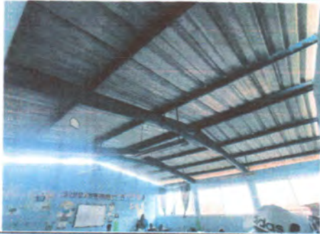
Foto1: SUMINISTRO E INSTALACIÓN DE LAMINA TROQUELADA CALIBRE 26
