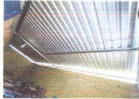
Foto 2: techo y estructura nueva de aula
