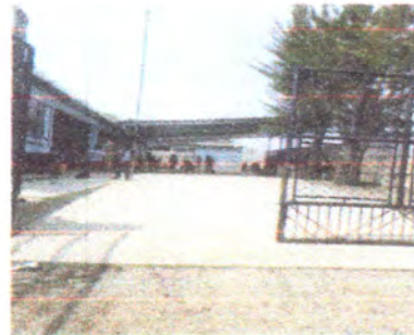
Foto 4: losa de patio terminada
