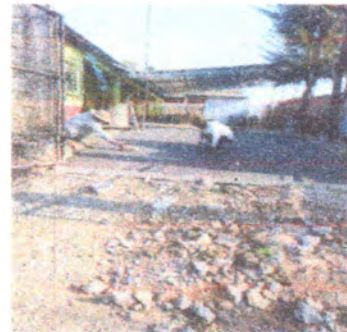
Foto 4: Fundición losa de patio
