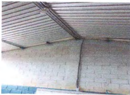
Foto 3: Sistema electrico reparado
