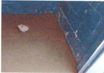
Foto 1: Red de drenaje reparado
