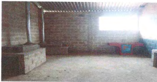
Foto 5: Colocación de pila y estufa rural reparado
