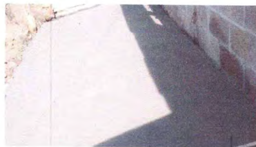
Foto 6: Losa de patio reparado
