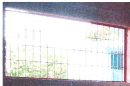
Foto 4: Colocación de ventana
