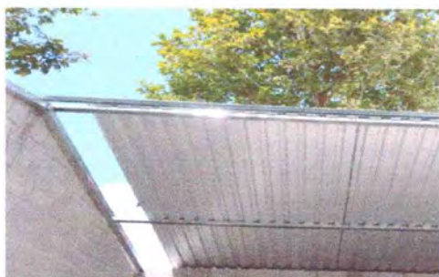
Foto 1: Cambio de techo
