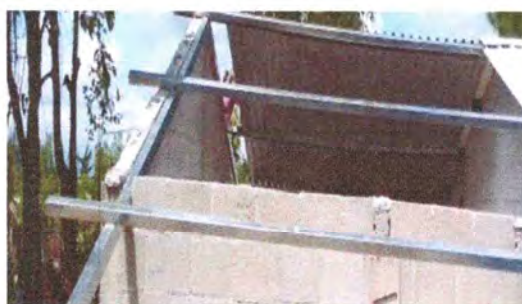
Foto 2: Cambio de estructura de techo
