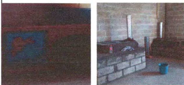
Foto 5: Sustitución de pila y estufa rural
