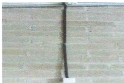
Foto 3: Sustitución cableado eléctrico
