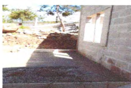
Foto 6: Sustitución de losa de patio
