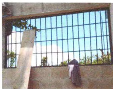
Foto 4: Sustitución de Ventana
