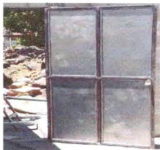
Foto 3: Sustitución de puerta
