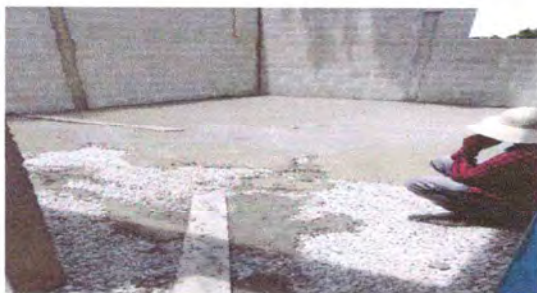
Foto 5: Fundición de piso
