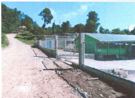
Foto1: Finalización de muro perimetral.
