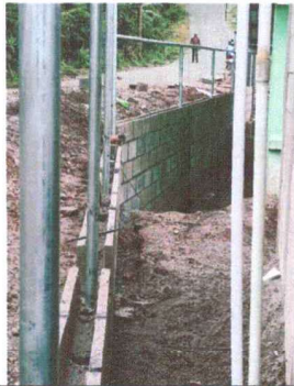
Foto1: Fundición y colocación de tubos.
