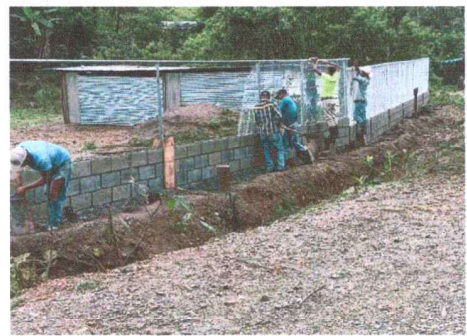
Foto 2: Colocación de malla.
