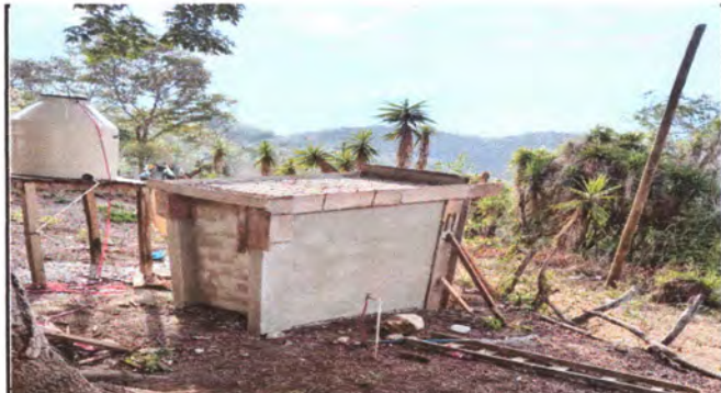
Foto 6: Fundicion de losa baños
