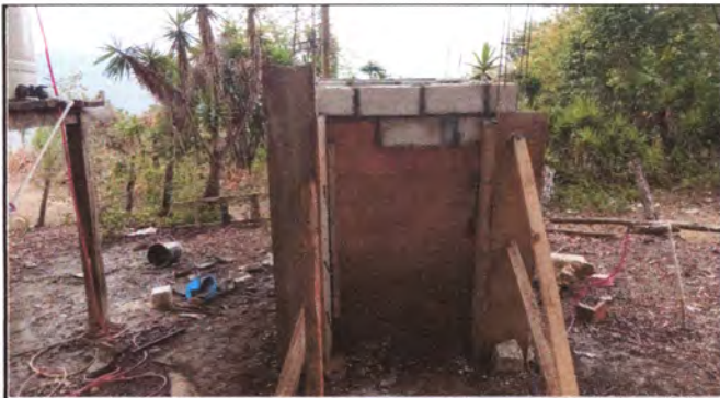
Foto 4: Reperacion de paredes baños
