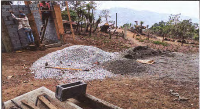
Foto1: Reparación paredes cosina
