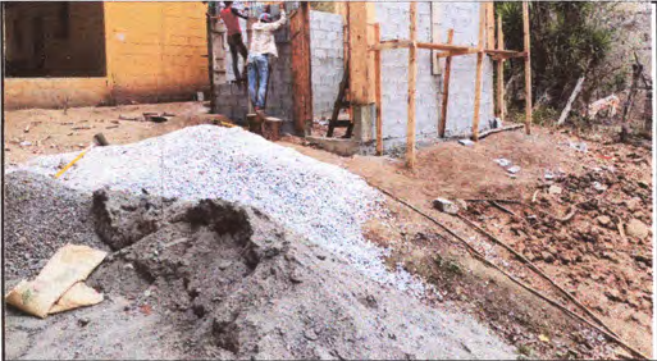
Foto 2: Reparacion de cosina
