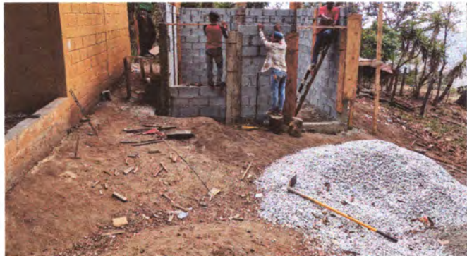
Foto 3: Reparacion de paredes
