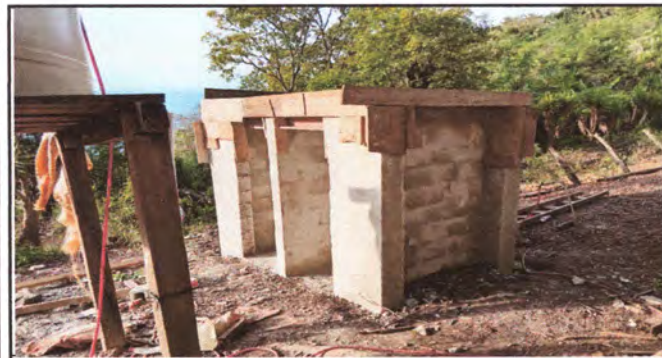
Foto 5: Reforzamiento de columnas baños
