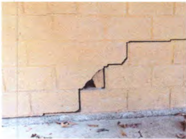
FOTO 2: Reparación de banqueta exterior de cocina
