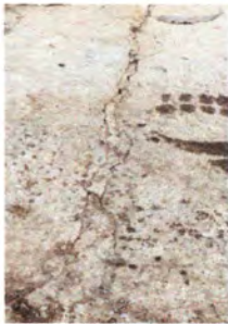
Foto: 6 Reparación de mesa de concreto
