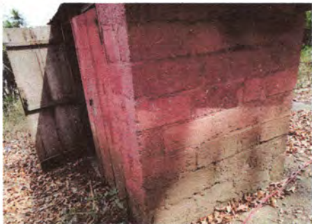
Reemplazo de puerta para baños
