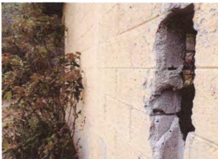
Foto4: Reparación de paredes de cocina
