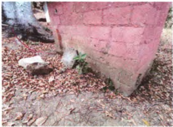
Foto1: Reparación de base para piso
