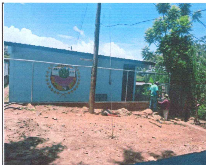
Foto 3: Muroperimetral con maya y tubo galvanizado
