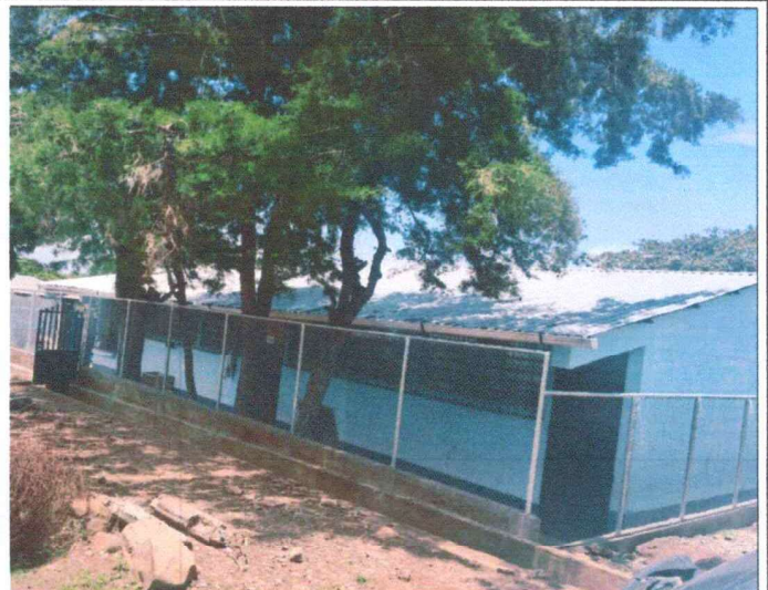
Foto 2: Muro de maya con tubo
