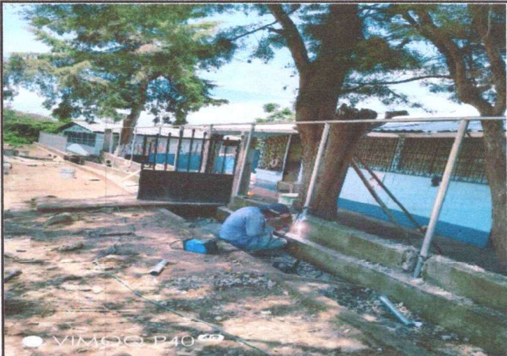
Foto 2: Soldadura de tubos galvanizados para muro perimetral.
