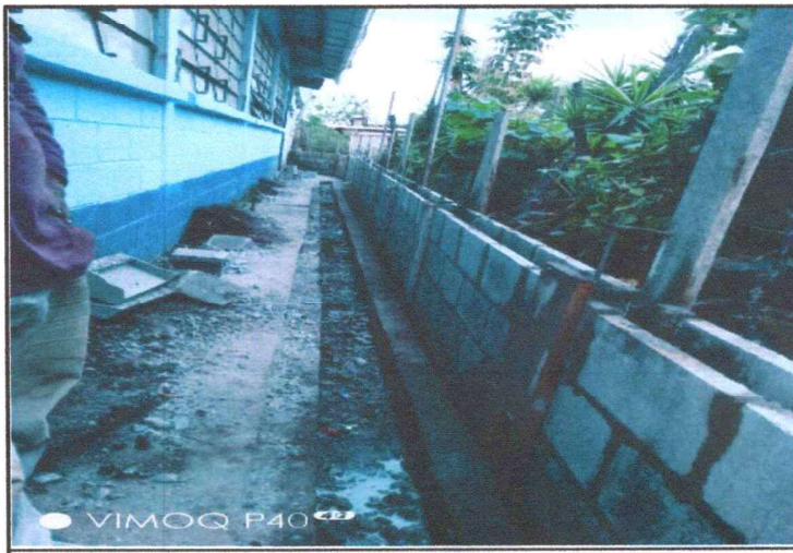
Foto 4: Reforzamiento muro perimetral que se encontraba dañado,
