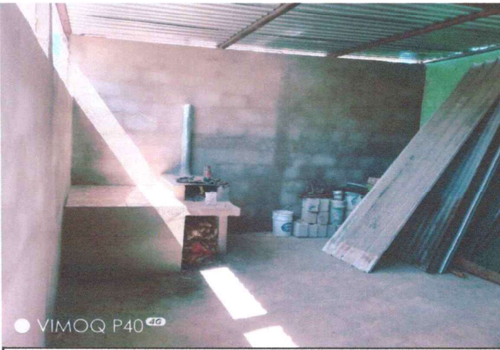
Foto 3: Repello y coloración de piso en área de cocina en proceso,
