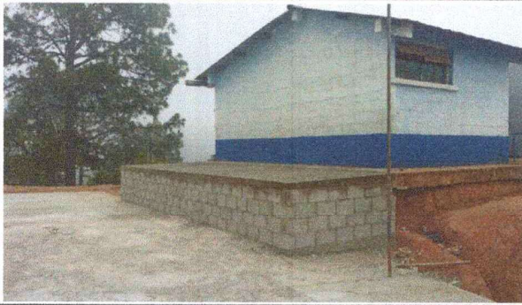
Foto 1: Losa de Patio
