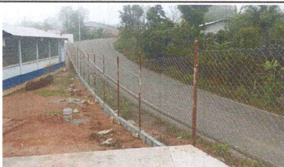
Foto 3: Cerco o muro perimetral
