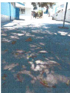
Foto 5: losa de cemento y pintura
