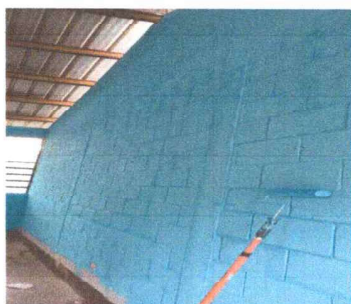
Foto 5: Pintura de paredes
