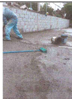
Foto 6: colocación losa de cemento
