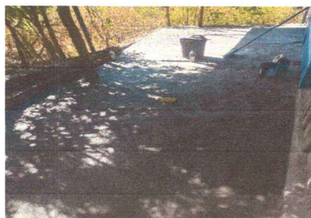
Foto 4: Preparando terreno para losa de cemento
