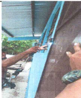
Foto 3: Reparación de Puertas
