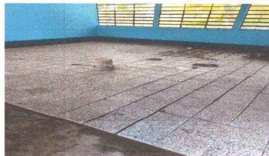
Foto 2: Colocación de Piso
