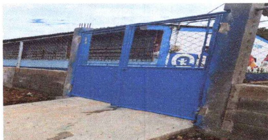
Foto 1: Levantado de pared y muro perimetral
