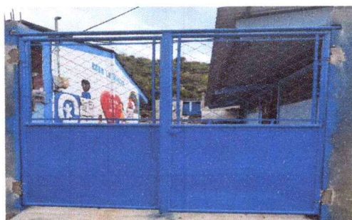
Foto 5: Sustitución de portón de tubo con lámina lisa
