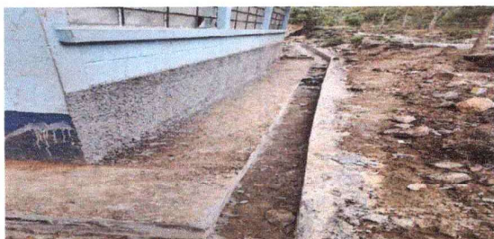
Foto 3: Mantenimiento, reparación y ampliación de cuneta
