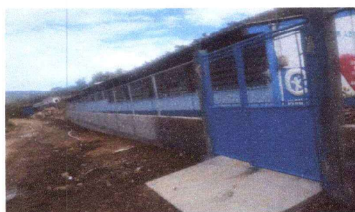
Foto 2: Reparación e instalación de malla metálica en muro
