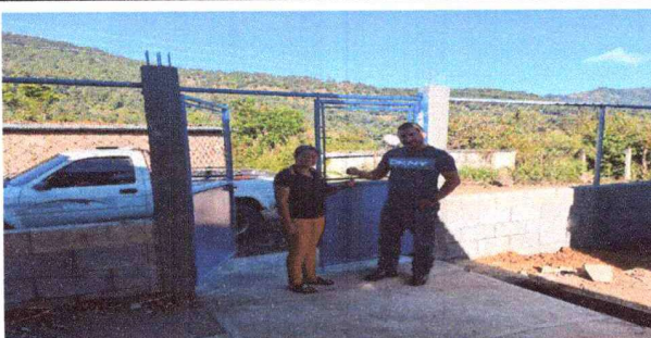
Foto 5: Sustitución de portón de tubo con lámina lisa
