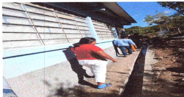
Foto 4: Trabajando el granciado por problemas de exceso de humedad
