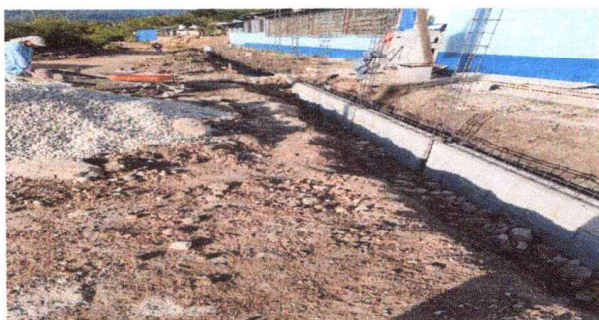
Foto1: Levantado de pared y muro perimetral
