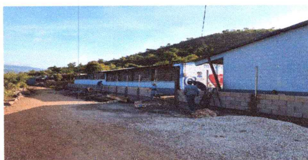
Foto 2: Reparación e instalación de malla metálica en muro
