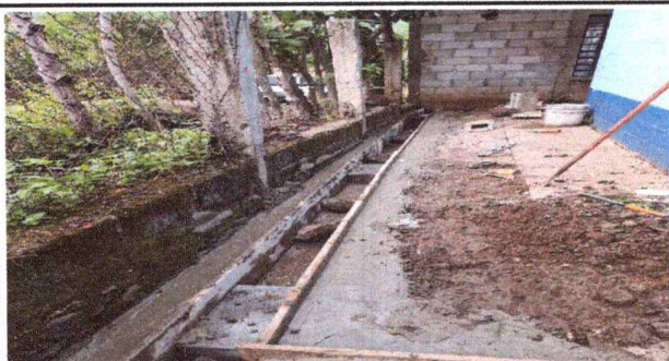
Foto 3: tranajando la Cuneta de concreto
