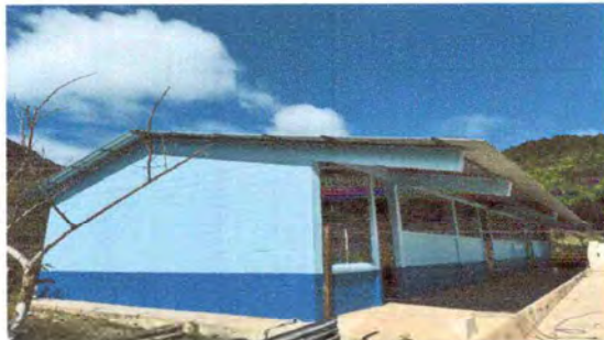
Foto 5: Pintura en muros exterior
