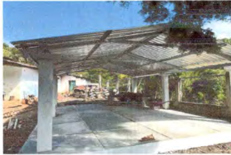
Foto 1: Cubierta de lámina
