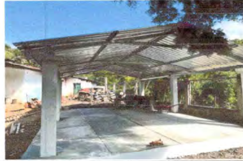
Foto 2: Estructura de techo
