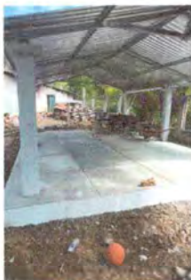
Foto 1: Sustitución losa de patio
