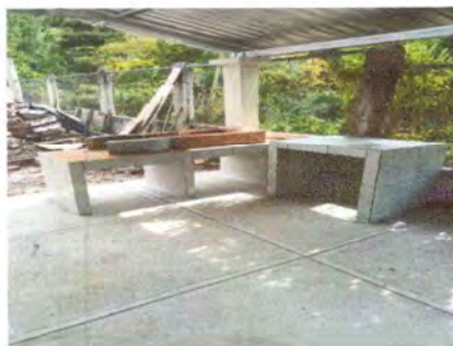
Foto 2: Sustitución de area de cocina (estufa rural)
