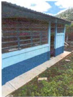
Foto 3: Sustitución de puertas
