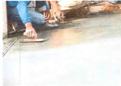
Foto 4: Sustitución de piso
