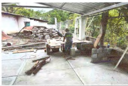
Foto 2: Sustitución de area de cocina (estufa rural)
