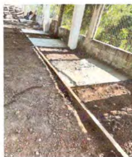
Foto 4: Sustitución de piso
