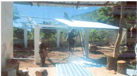
Foto1: Cubierta de lámina
