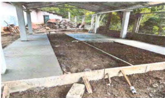
Foto 1: Sustitución losa de patio
