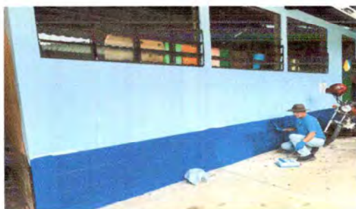
Foto 5: Pintura en muros exterior
