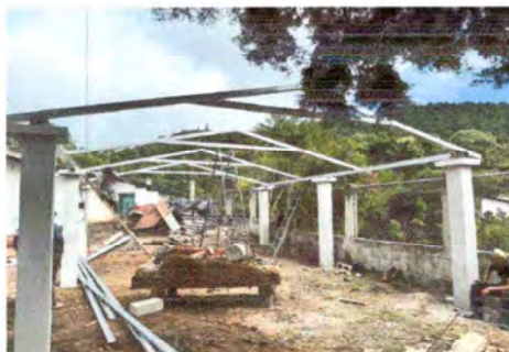
Foto 2: Estructura de techo
