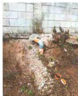
Foto 6: Reparación de red de drenaje
