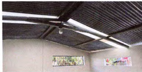
Foto 2: Soporte de estructura agregado.
