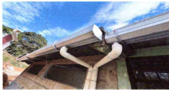
Foto 8: Bajadas de agua finalizadas.
