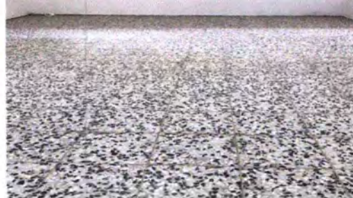
Foto 6: Colocación de piso terminado.
