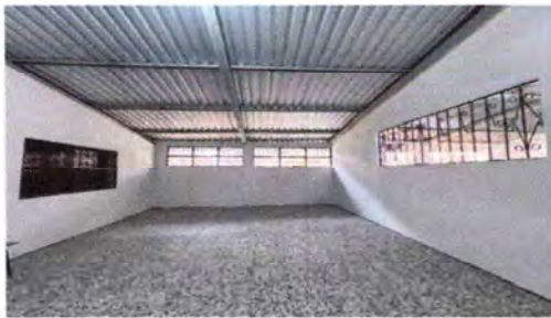
Foto 9: Paredes repelladas.
