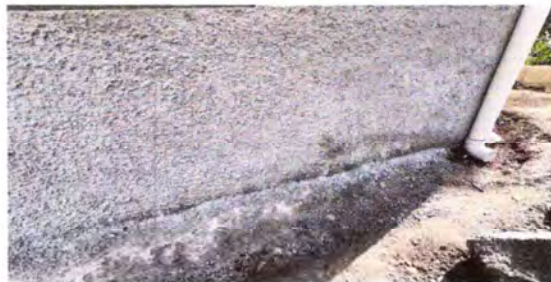
Foto 10: Repello tipo granceado terminado.
