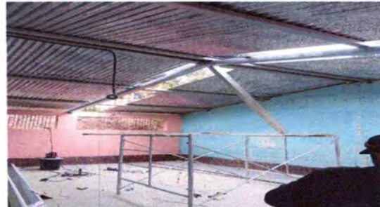
Foto 2: Colocación de soporte a la estructura.
