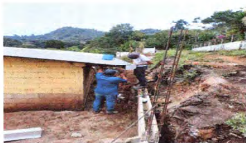
Foto7: Colocación de canales.
