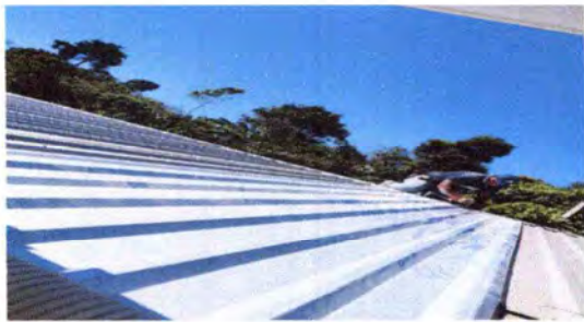
Foto1: Desmontaje y colocación de lámina.
