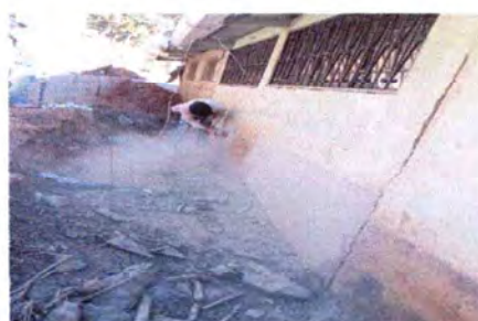
Foto 10: Limpieza y colocación de repello tipo granceado.
