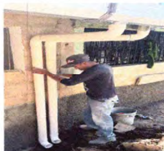
Foto 8: Colocación de bajadas de agua.
