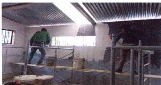
Foto 9: Repellando paredes.
