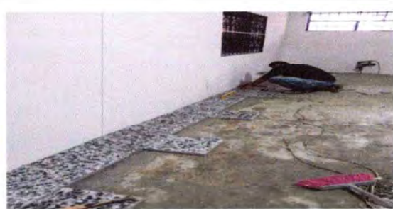
Foto 6: Colocación de piso de granito.
