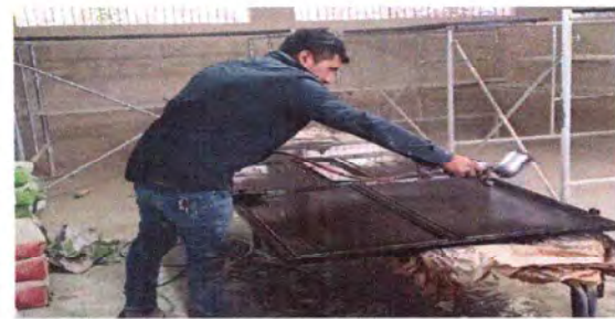
Foto 3: Colocación de puerta.
