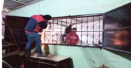
Foto 4: Colocación de ventana.
