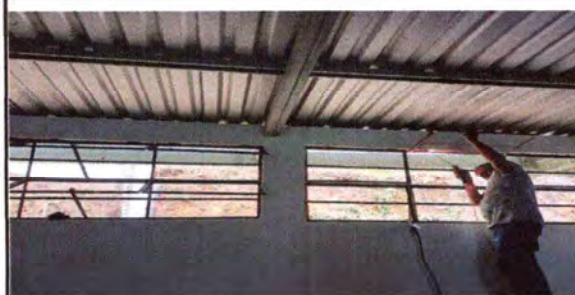
Foto 5: Colocación de vidrios.
