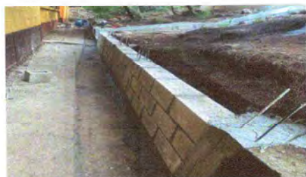
Foto 11: Muro de contención en proceso
