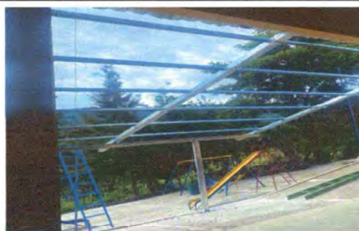
Foto 4: Complemento de estructura en galera
