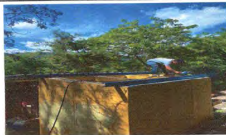
Foto 8: Cubierta de lamina para sanitarios en proceso
