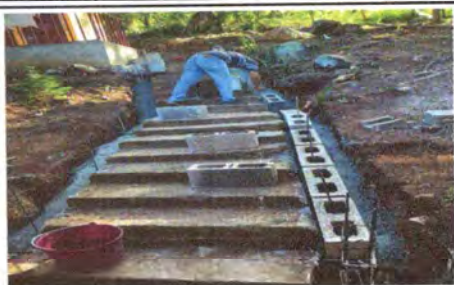
Foto 7: Muro de contención de gradas en proceso
