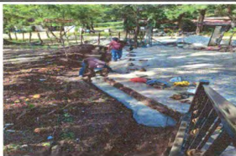
Foto 6: Mantenimiento de cuneta de concreto
