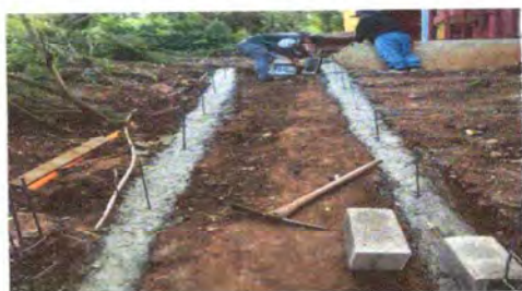
Foto 9: Mantenimiento de gradas en proceso
