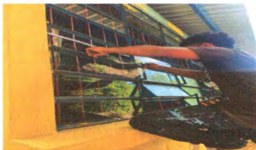
Foto 5: Reposición de vidrios en proceso
