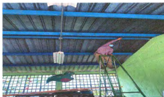
Foto 2: Mantenimiento de estructura metalica
