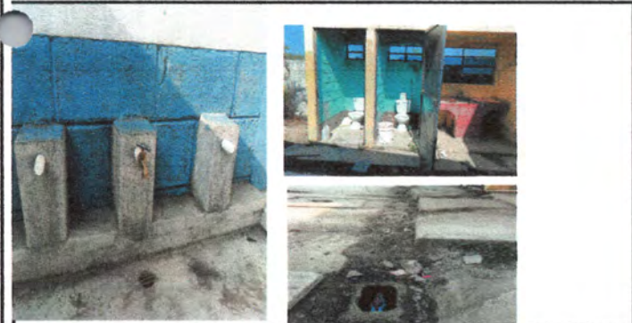
Foto 5: reparacion de instalacion de agua, y modulos de sanitario
