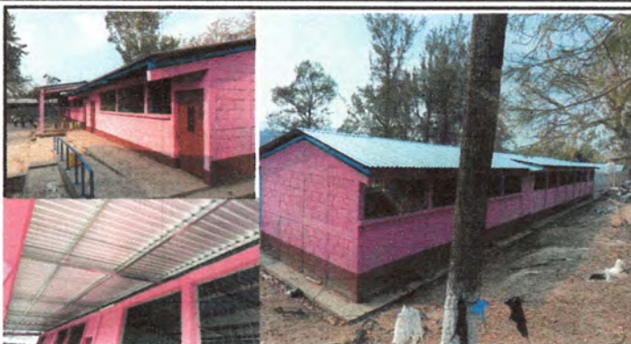
Foto 2: cambio de lamina acanalada a lamina troquelada
