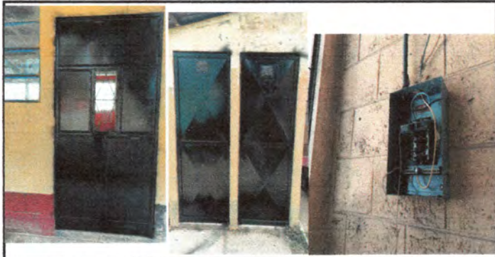
Foto 6: reparacion de puertas y sistema electrico
