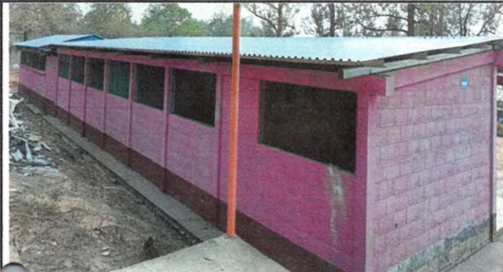
Foto 1: Cambio de duralita a lamina troquelada y costanera galvanizada
