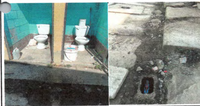
Foto 5: reapaación sistema de agua y recuperación de modulo de sanitario
