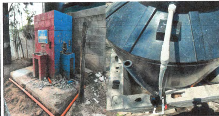
Foto 3: reparación de modulo de lavamanos y tinaco
