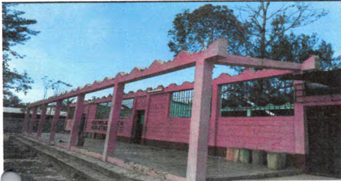
Foto1: Cambio de duralita a lamina troquelada y costanera galvanizada
