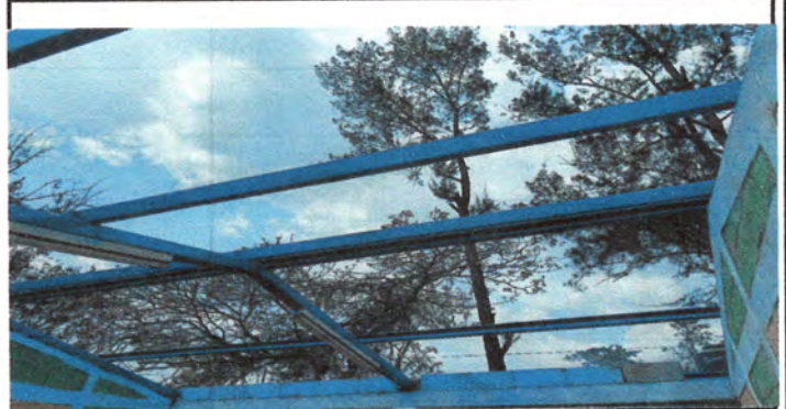
Foto 2: cambio de lamina acanalada a lamina troquelada
