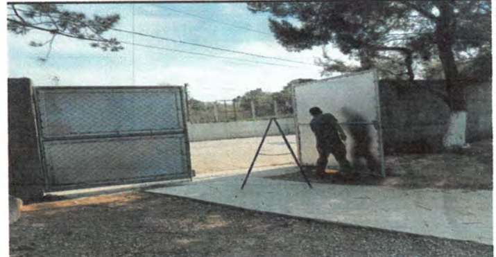
Foto 4: reapaación, cambio de maya y colocación de lamina a puerton
