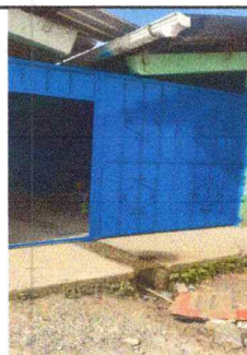
Foto 6: MANTENIMIENTO A PORTONOS
