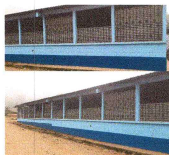
Foto 4: PINTURA EN MUROS INTERIOR Y EXTERIOR
