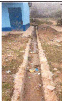
Foto 3: CUNETETA DE CONCRETO
