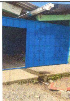
Foto 6: MANTENIMIENTO A PORTONOS
