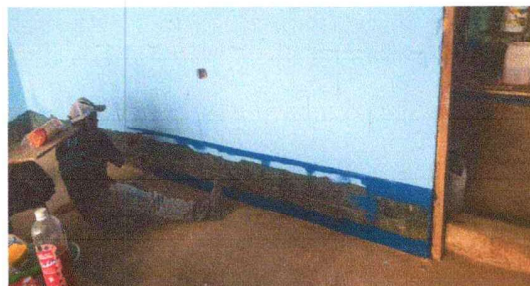
Foto 4: PINTURA EN MUROS INTERIOR Y EXTERIOR
