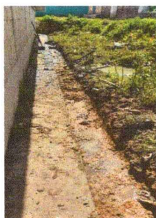
Foto 3: CUNETA DE CONCRETO
