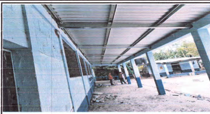
Foto 2: Estructura y cubierta de lámina reparada de los corredores del centro educativo.
