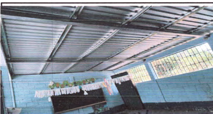
Foto 4: Reparación de techo de modulo 2. Finalizada
