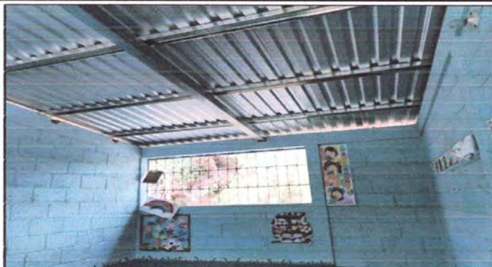
Foto1: Estructura y cubierta de lámina reparada.
