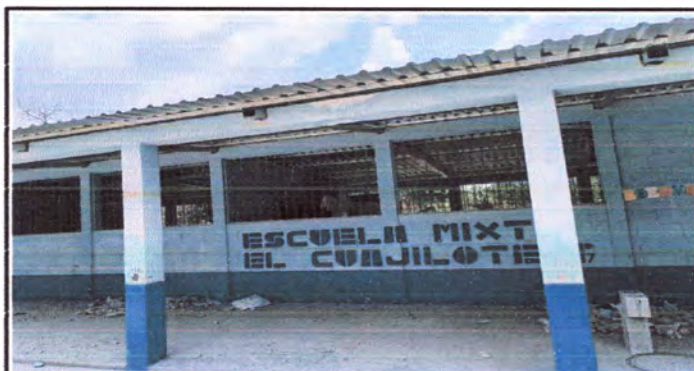
Foto 3: Reparación de techo de modulo 1. Finalizada
