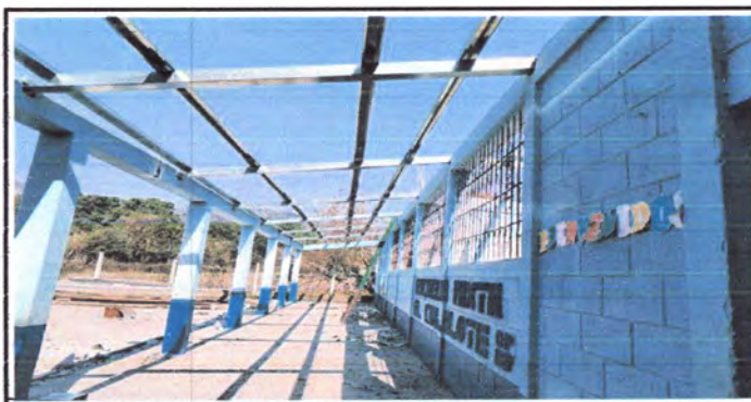
Foto 6: Colocación de nueva cubierta de lámina.
