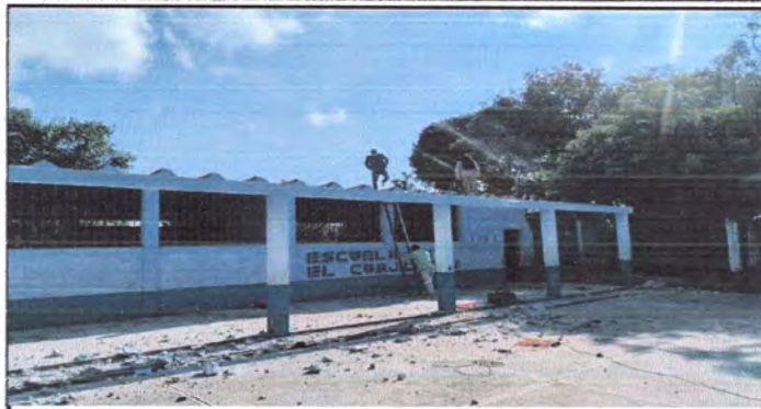
Foto 1: Desmontaje de techo.
