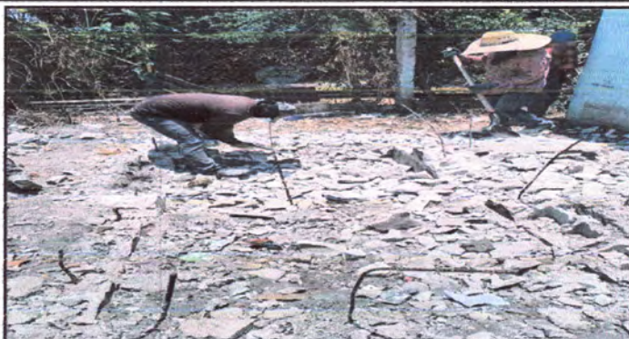
Foto 2: Demolición de Fosa Séptica en mal estado.
