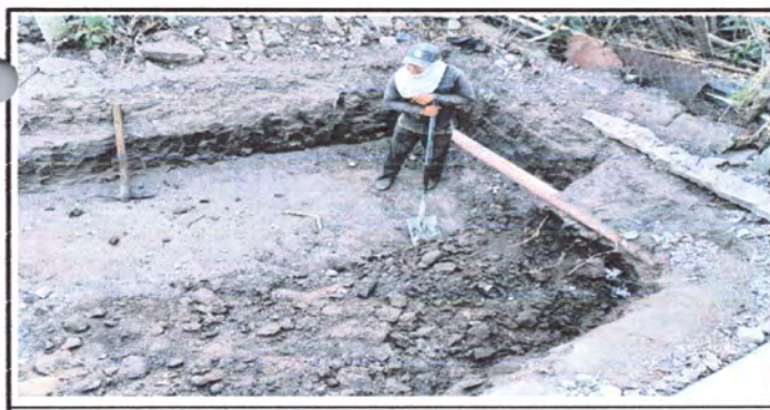
Foto 5: Preparación de terreno para reparación de Fosa Séptica.
