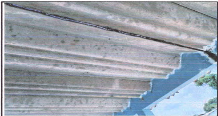
Foto3: Cambio de techo
