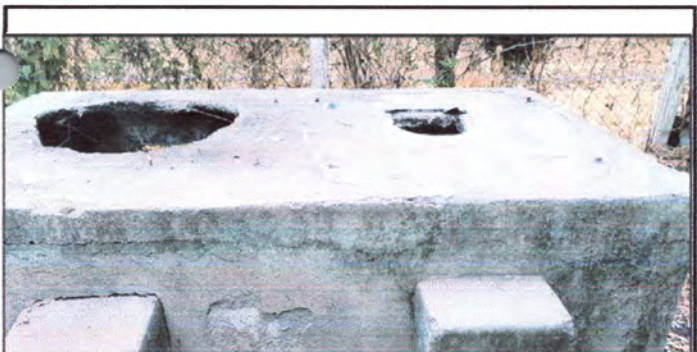
Foto 5 Reparación y mantenimiento de fosa séptica
