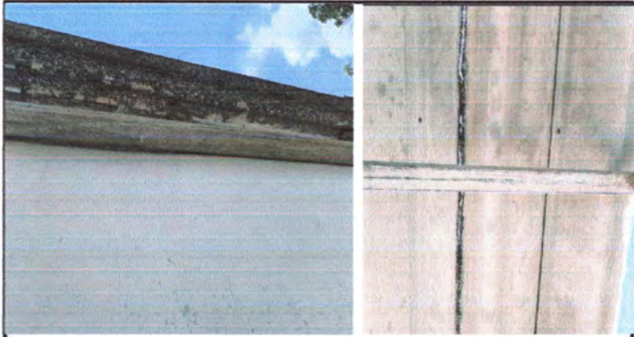
Foto1: Reparación de estructura de techo
