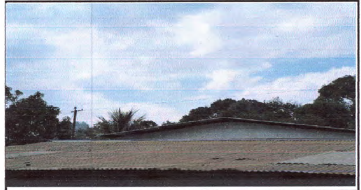
FOTO 2: Sustitución de techo
