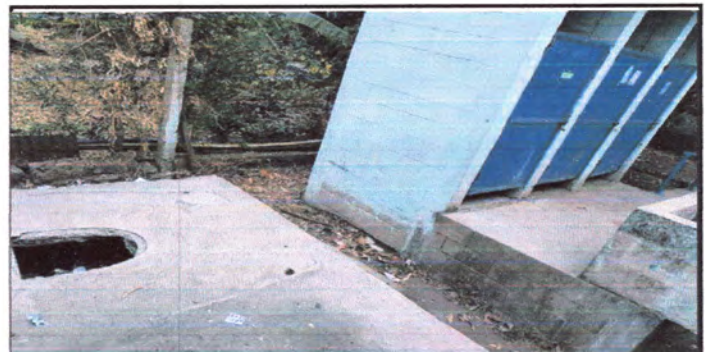
Foto 6 Mejoramiento de drenaje de los sanitarios
