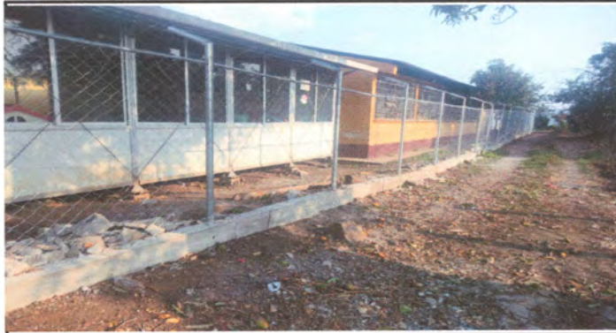
Foto 1: finalización de la sustitución de maya y postes
