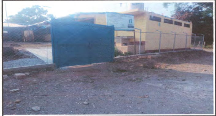
Foto 2: finalización de la sustitución del porton principal
