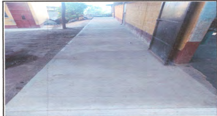
Foto 4: finalización de la sustitución de la losa para patio
