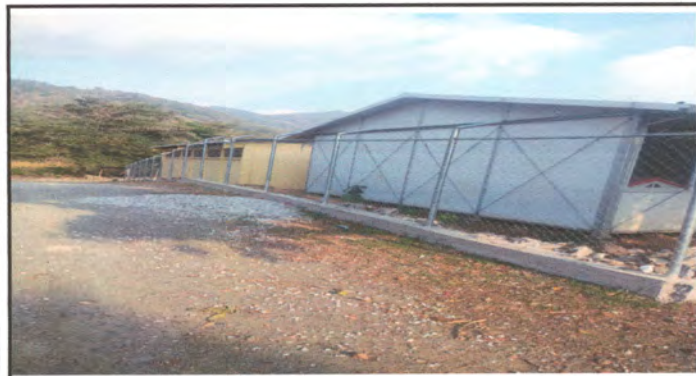
Foto 3: Finalización de la sustitución de maya y postes
