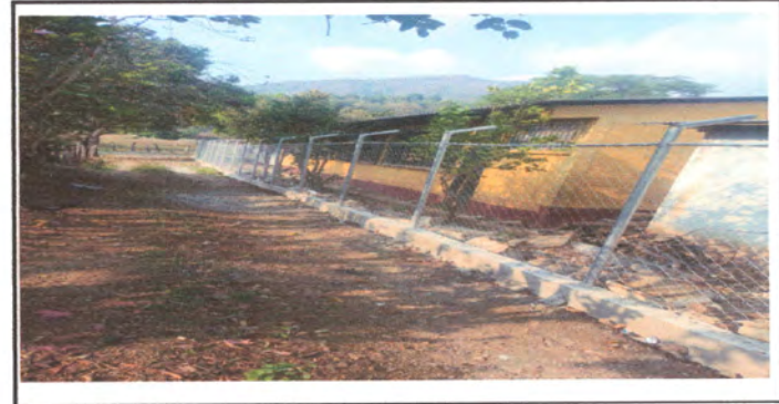
Foto 6: finalización de sustitucion de maya
