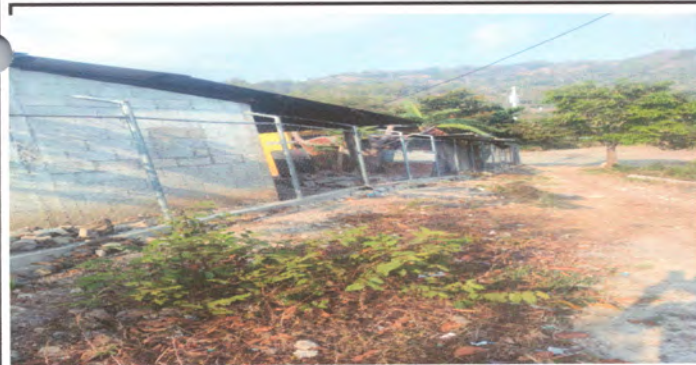
Foto 5: finalización de la sustitución de maya
