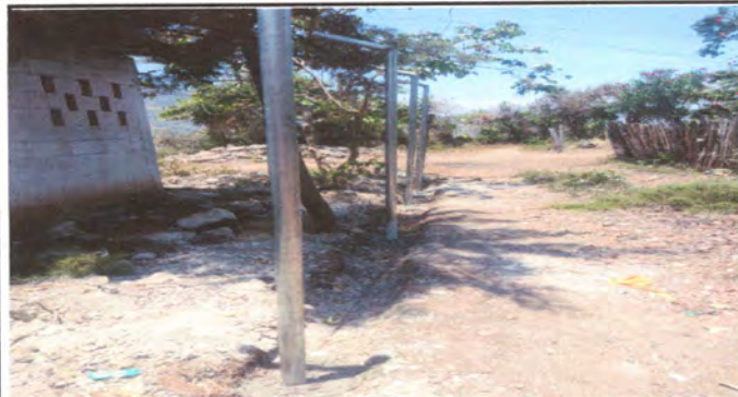
Foto 1: avance de cambio de postes
