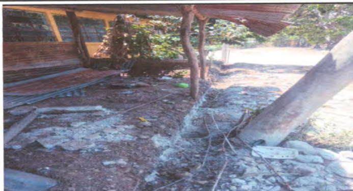
Foto 2: avance de sustitucion de maya y postes
