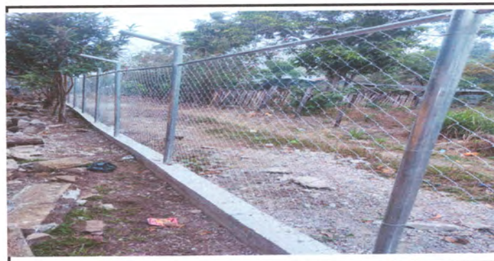
Foto 6: avance de la sustitucion de maya y postes
