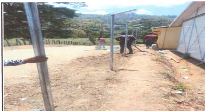
Foto 4: avance en la sustitucion de postes
