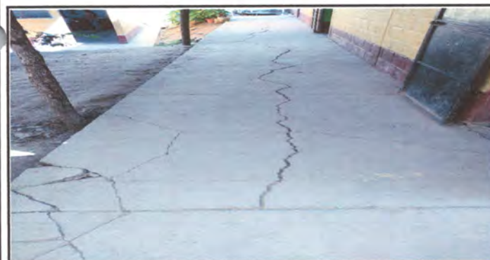
Foto 5: fundicion de losa para patio
