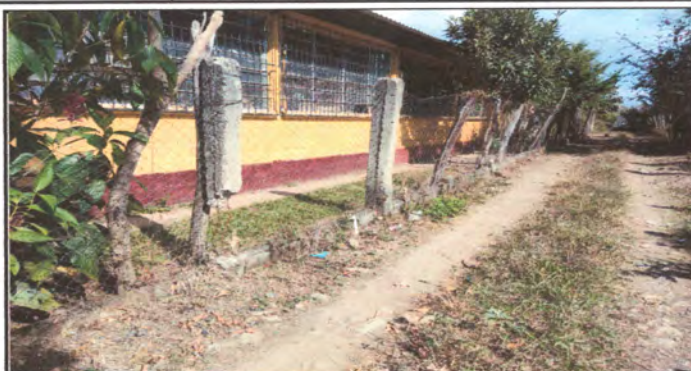
Foto 2: sustitucion de maya trasera
