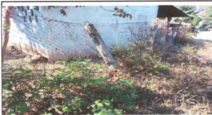
Foto 1: sustitucion de postes
