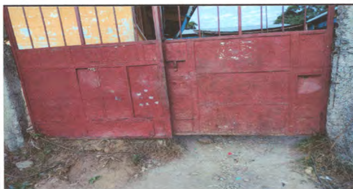
Foto 3: sustitucion de porton
