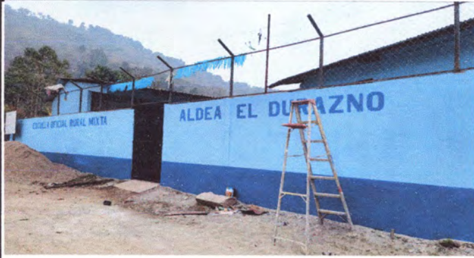
Foto1: Reparacion de la circulacion del establecimiento Finalizado
