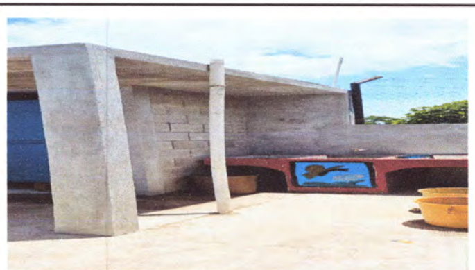
Foto 4: Proceso de fosa Finalizado
