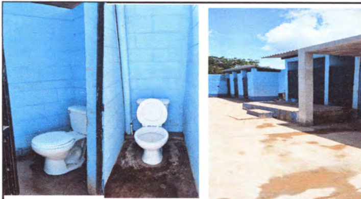
Foto 3: Reparacion de baños Finalizado
