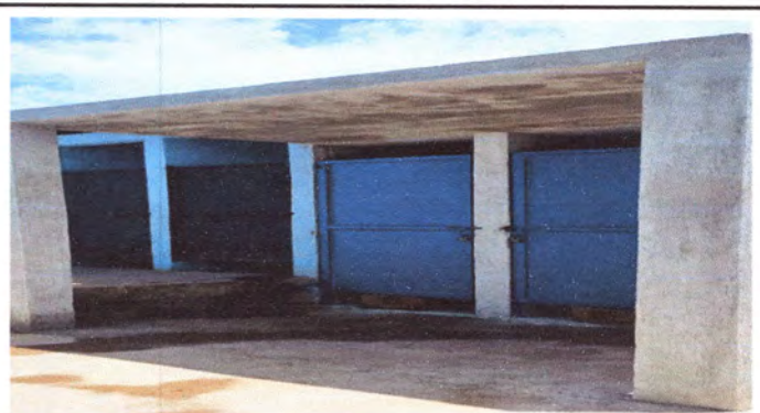
Foto 2: Reparacion de puertas Finalizado
