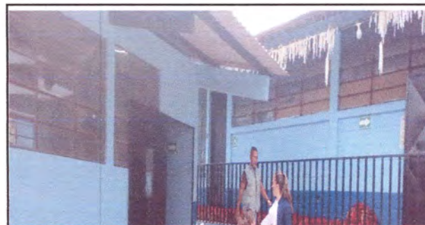
Foto 6: Cambio de techo de lamina finalizado
