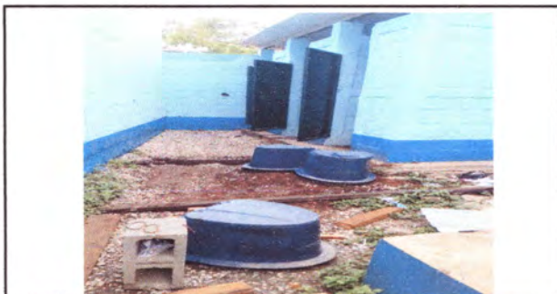
Foto 3: Reparacion de baños en proceso
