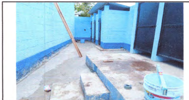
Foto 2: Reparacion de puertas finalizada
