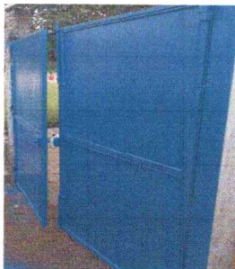
Foto 5: Mantenimiento a Portones
