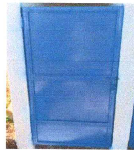
Foto 4: Reparación de puertas en baños.
