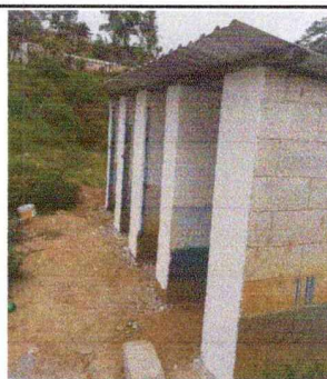
Foto 4: Reparación de puertas en baños.
