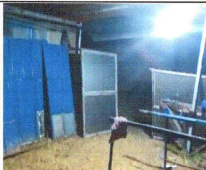
Foto 3: Reparación de puertas
