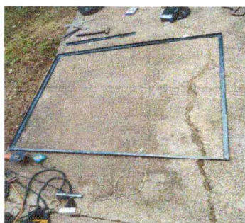
Foto 5: Mantenimiento a Portones
