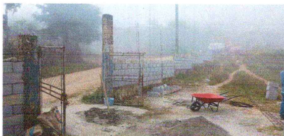
Foto 1: Cerco o Muro Perimetral
