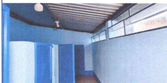
Foto 5: Mantenimiento de servicios de sanitarios.
