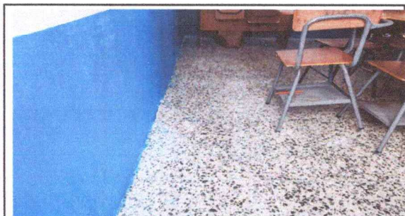
Foto 3: Instalacion de piso de granito
