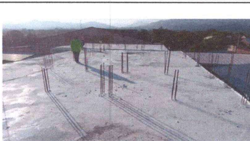
Foto 2: Aplicación de impermeabilizante en terraza.
