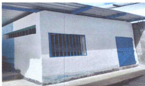
Foto 4: cambio de techo y repello.
