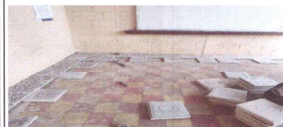
Foto 5: Instalacion de piso de granito
