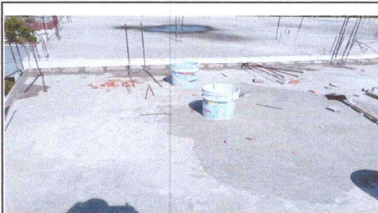
Foto 2: Aplicación de impermeabilizante en terraza.
