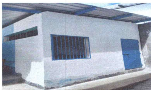
Foto 4: cambio de techo y repello.
