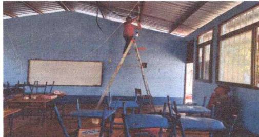
Foto 6: mantenimiento del sistema Electrico
