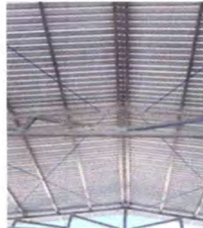
Foto 2: Estructura de techo
