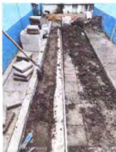
Foto 5: Reparación Red de drenaje
