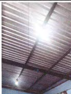
Foto 8: Reparación de Sistema electrico
