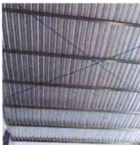
Foto1: Cubierta de lámina
