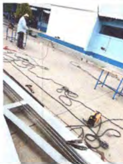
Foto 2: En proceso estructura de techo
