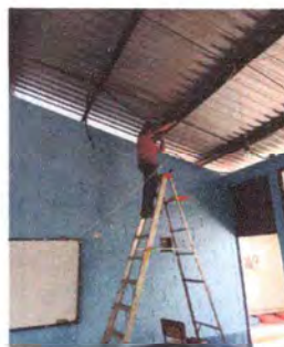
Foto 8: Reparando el Sistema electrico
