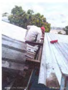
Foto 3: En proceso impermeabilización de techo
