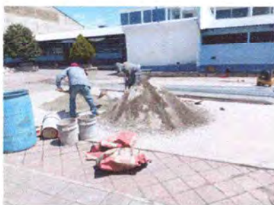
Foto 7: En proceso losa de patio
