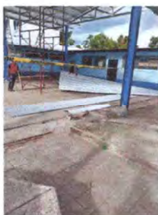
Foto1: En proceso cubierta de lámina
