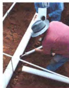
Foto 6: En proceso reparación de agua potable
