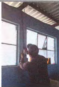
Foto 9: Reparación de sistema electrico fuerza
