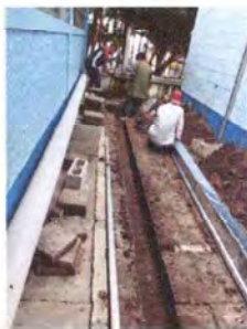
Foto 5: En proceso reparación Red de drenaje
