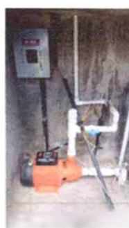
Foto 10: Mantenimiento de cisterna
