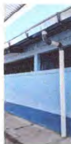
Foto 6: Canales y bajadas pluviales
