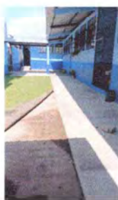
Foto 11: Losa de patio
