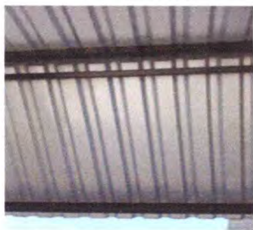
Foto1: Cubierta de lámina
