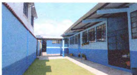
Foto7: Pintura en muros interior y exterior
