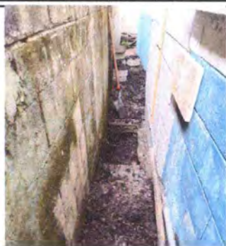
Foto 13: Trabajando Red de drenaje
