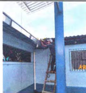
Foto 6: Trabajando en Canales y bajadas pluviales
