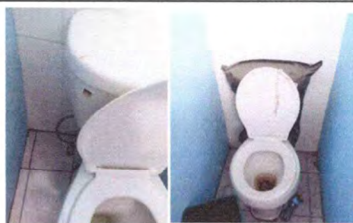
Foto 8: Reparando Servicios Sanitarios
