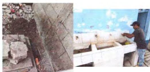
Foto 14: Trabajando Red de agua Potable
