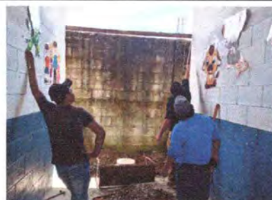
Foto 12: Trabajando muro perimetral
