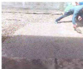
Foto 11: Trabajando en Losa de patio
