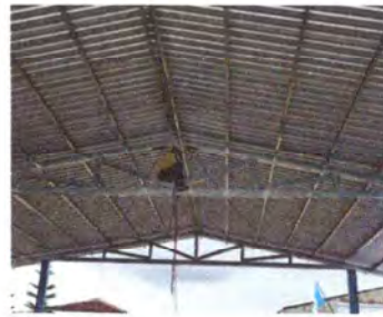
Foto 2: Colocacion de estructura de techo
