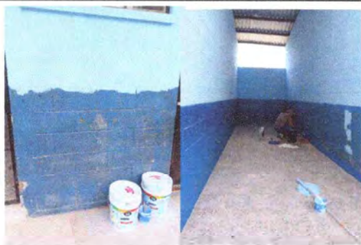
Foto7: Pintando los muros en interior y exterior
