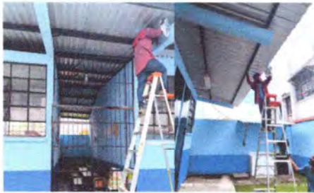
Foto1: En proceso de Cubierta de lámina
