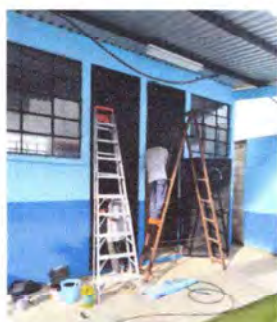
Foto 15: Reparación del sistema eléctrico
