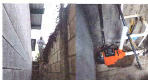
Foto 10: Dandole mantenimiento de cisterna
