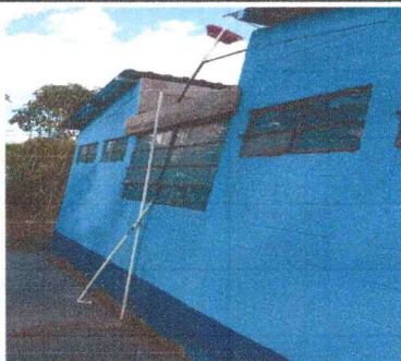
Foto1: paredes pintadas e instalación de nueva tubería
