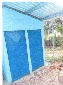
Foto 2: puertas reparadas area de sanitarios
