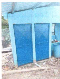
Foto 3: techo reparado en area de sanitarios
